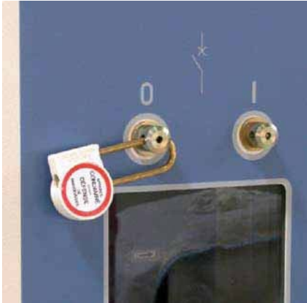
Fig. 10.11 Déclenchement manuel du disjoncteur bloqué par cadenas
