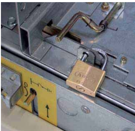
Fig. 10.13 Verrouillage du tiroir (en option)
